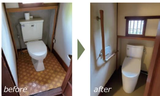
洋式トイレは新しいものに取り替えてL字型の手すりを設置しました。立ち上がりの動作がしやすいです。
