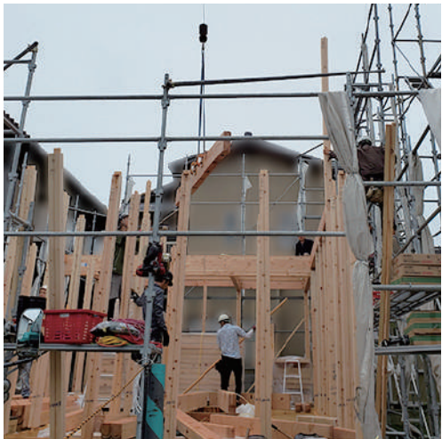
①建て方は、1階の柱をたてるところから始まります。
