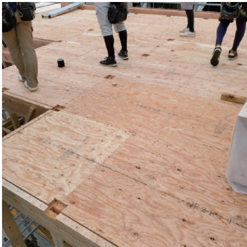
③2階部分に構造用合板が敷かれ、床が出来ました。
