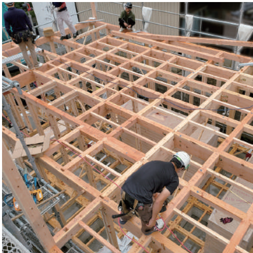
②1階の柱の上に梁を固定して2階の床組みをします。
