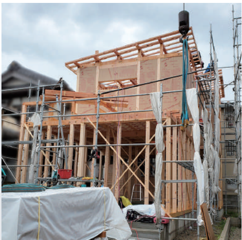
⑤小屋組み（屋根の骨組み）が出来て壁に木質パネル（断熱材が一体になったパネル）を設置していきます。
