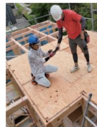
④ 天井部の梁（小屋梁）から上に小屋束（こやづか）、母屋（もや）、垂木（たるき）、火打梁（ひうちばり）、棟木（むなぎ）、野地板（のじいた）と設置していきます。これらを小屋組み（こやぐみ）と言い、屋根を支える屋根根の骨組みのことです。一番上の材料までつなげれば、いわゆる上棟（棟上げ）です。
