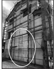
E様邸外壁工事が完成しました！建築してから、二十数年余り経過していました。その為、工事前は左の写真の様に外壁は劣化していました。特に白丸で囲ってある部分の劣化が激しかったです。このままでは、雨水などが壁の中にまで浸透し、外壁の強度が落ちてしまいます。
