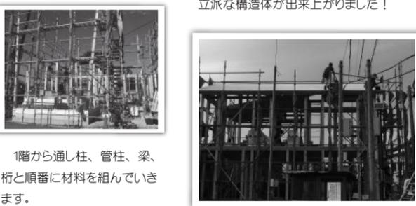
1階から通し柱、管柱、梁、桁と順番に材料を組んでいきます。
