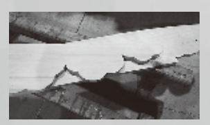
③改修に使用する材は東濃ヒノキを使用します。文様は手作業でカットしていきます。
